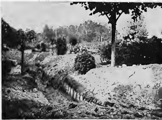
TRENCHES IN THE GARDENS OF THE HÔTEL-DE-VILLE.
